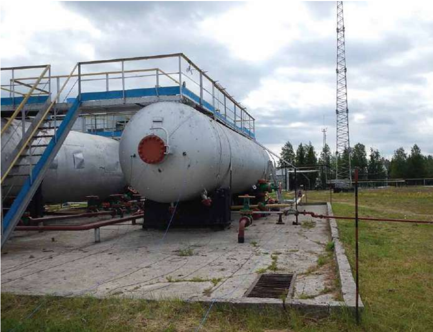
Рис. 1. Сосуд-разделительная емкость (объект исследования)
